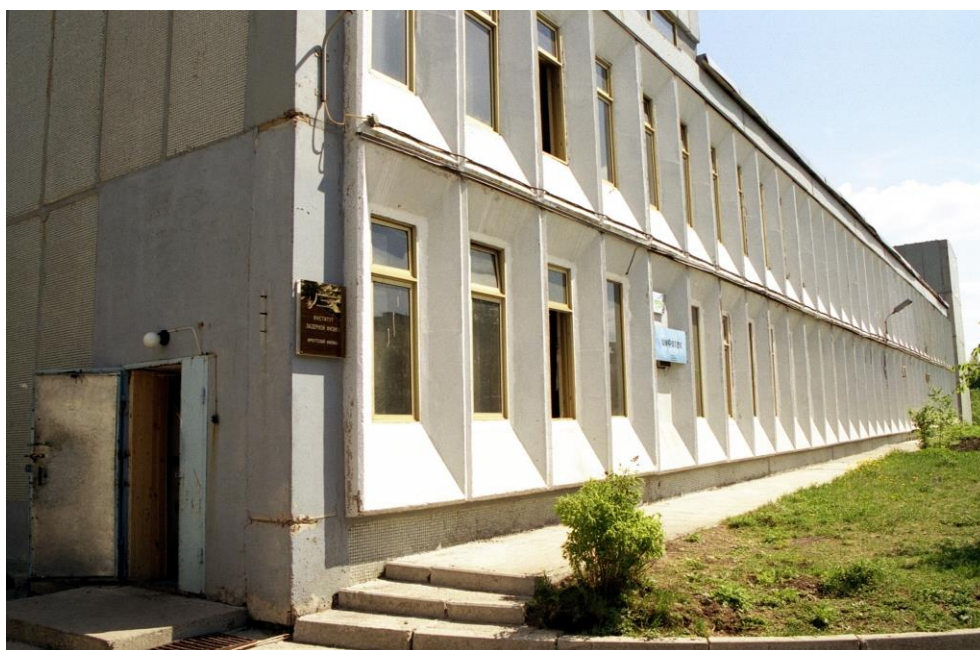
Здание ИФ ИЛФ СО РАН, Иркутск, ул. Лермонтова, 130а
