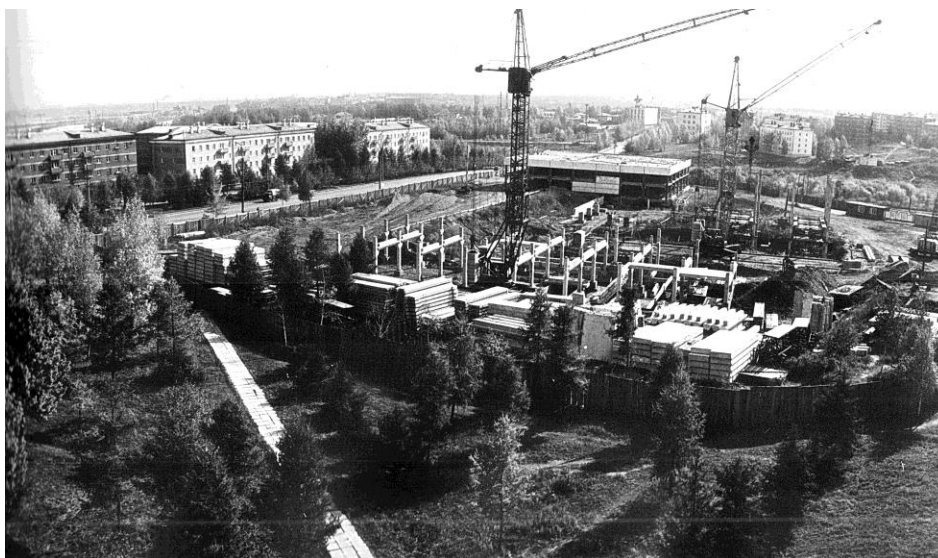
Строительство корпуса ИрВЦ СО АН СССР
