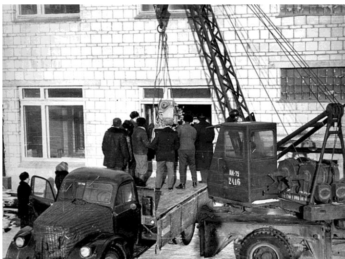
Сотрудники ИГХ СО АН СССР участвуют в установке оборудования в новое здание
