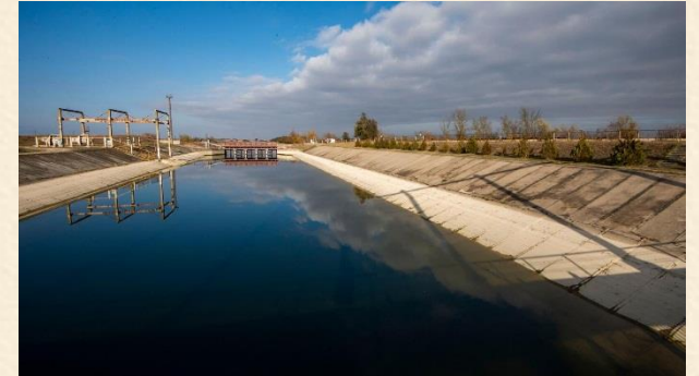
Северо-Крымский канал, 2023 г. Фото РИА Новости
