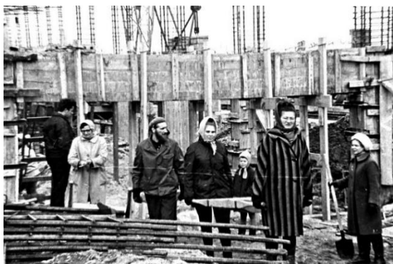
Строительство здания Института географии Сибири и Дальнего Востока СО АН СССР
