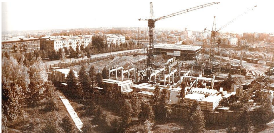
Строительство корпуса Иркутского вычислительного центра СО АН СССР
