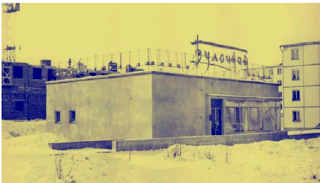
Магазин «Булочная». Слева на заднем плане виден строящийся дом № 289
