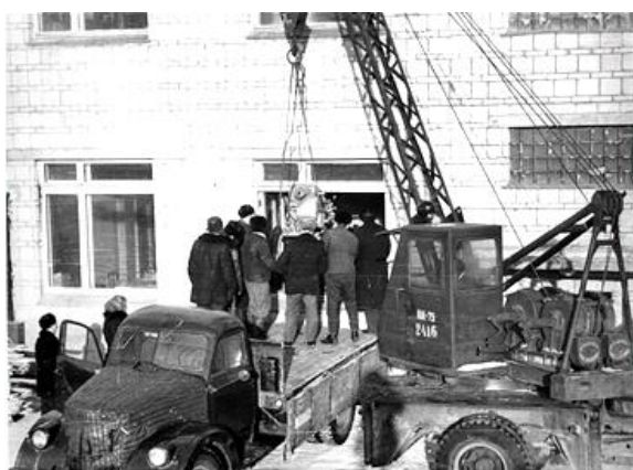
Установка оборудования в здание Института геохимии СО АН СССР Фото из архива института
