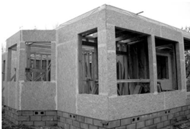
Рис. 4. Каркасно-панельная технология
