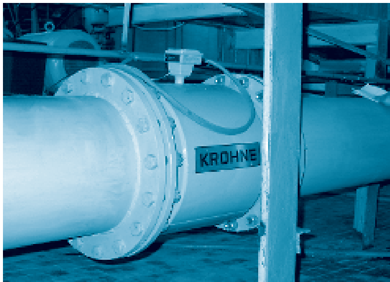
Рис. 1. Электромагнитный расходомер OPTIFLUX в системе водоснабжения г. Тобольска.
