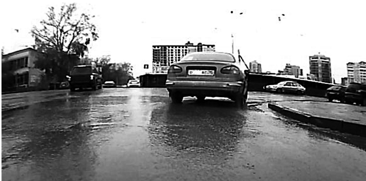
Рис. 2. Участок дороги в дождливую погоду
