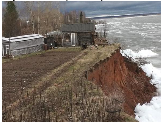
Рис. 3. Разрушение построек (бани) в микрорайоне Шичатка г. Чермоз, строения по ул. Заречная, №3 в результате увеличения эрозии берега
