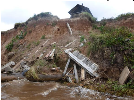
Рис. 3. Разрушение построек (бани) в микрорайоне Шичатка г. Чермоз, строения по ул. Заречная, №3 в результате увеличения эрозии берега
