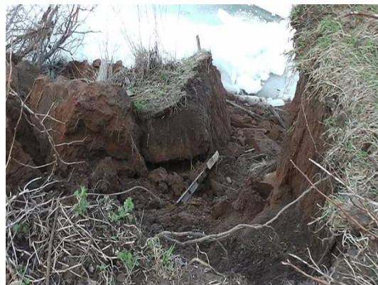
Рис. 1. Обрушение глыб берегового уступа Чермозского пруда в результате увеличения эрозии берега
