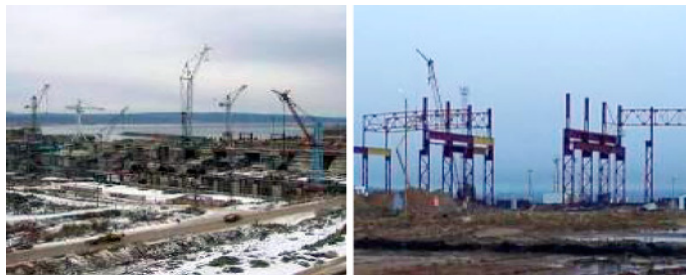
Рис. 26. Строительная площадка Богучанского алюминиевого завода
