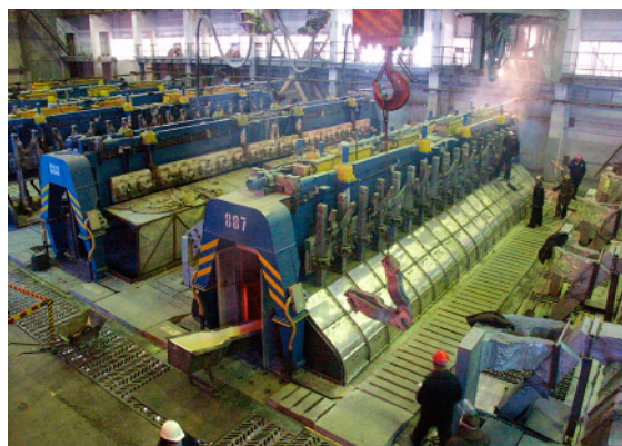
Рис. 16. Подготовка к пуску электролизера № 887
