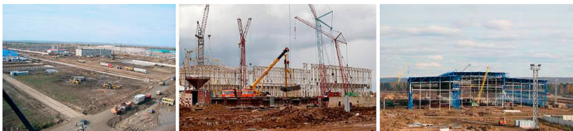
Рис. 27. Строительная площадка Тайшетского алюминиевого завода
