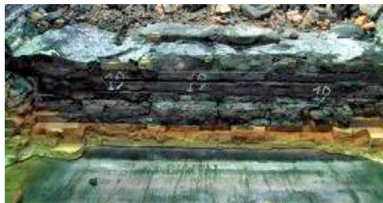
Рис. 19. Состояние футеровки РА-300
