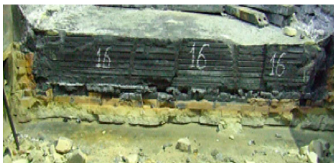
Рис. 25. Состояние футеровки РА-400
