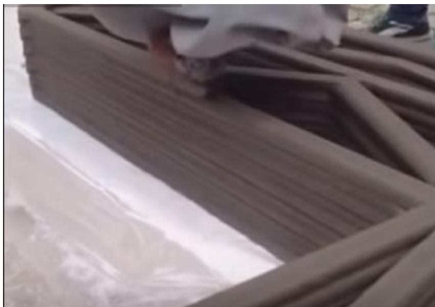
Рис.2. Технология послойного печатания
