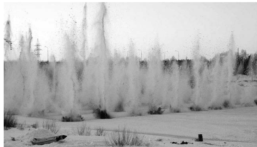
Рис. 3. Проведение взрывных работ на дне реки
