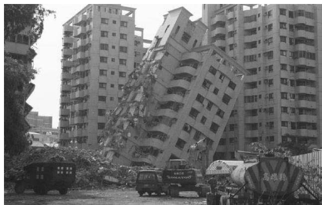
Рис. 2. Рухнувшее 7-ми этажное здание в г. Ван
