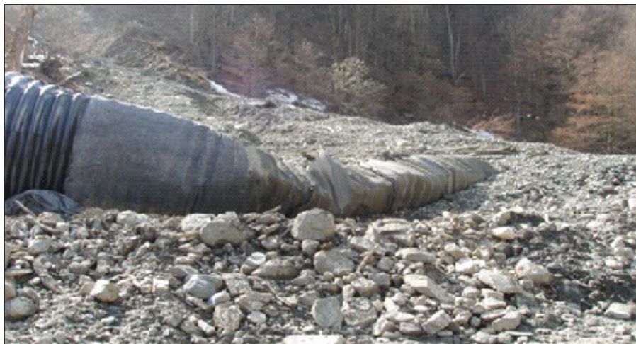
Рисунок 2. Сооружаемая противоселевая труба была разрушена первым селевым потоком. Фото Ю. Ефремова. Март 2012 г.
