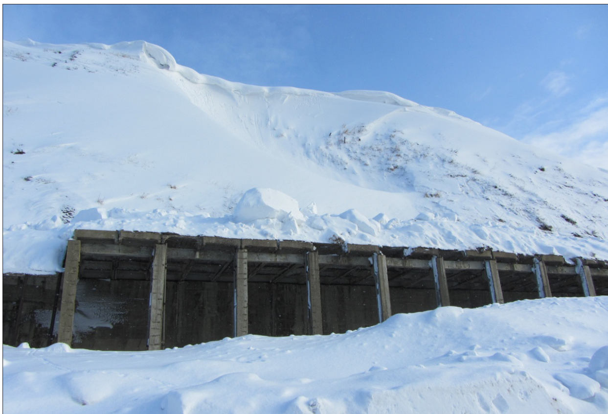
Рисунок 1. Снежный карниз. Автомобильная дорога Шебунино - Невельск. 2012 г. Толщина карниза до 3 м, ширина нависающей части до 3 м, длина – 50 м.
