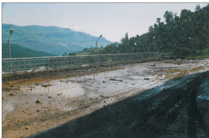
Рисунок 3. Фрагмент смотровой площадки ДТС после прохождения селя в г. Дилижане.
