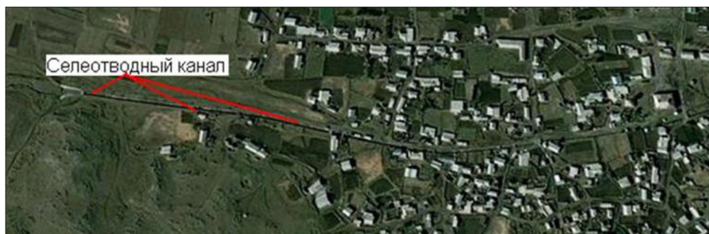
Рисунок 2. Селеотводящий канал поселка Цахкаовите на склоне горы Арагац.
