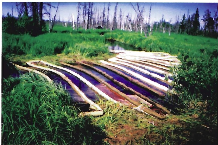
Нефтесобирующие бонны биоконвейера. Ручей, Суторминское м/е, К-57 (ОАО «СИБНЕФТЬ-НОЯБРЬСКНЕФТЕГАЗ»)
