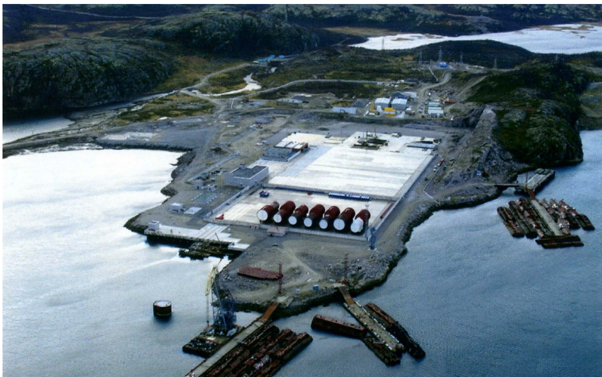
Рис. 1. Общий вид площадки ЦКДХ РАО в период строительства.
