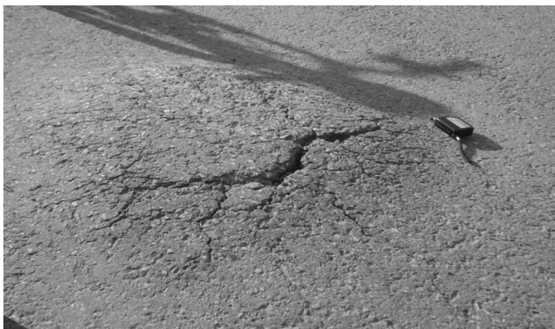
Рис. 3. Бугор пучения на улице Интернациональной (июнь 2012г.)
