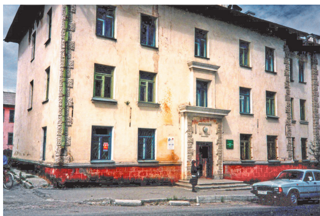
Первое здание ВНИИ-1 МВД СССР, введённое в строй в 1949 г. Это же и первое здание СВКНИИ СО АН СССР
