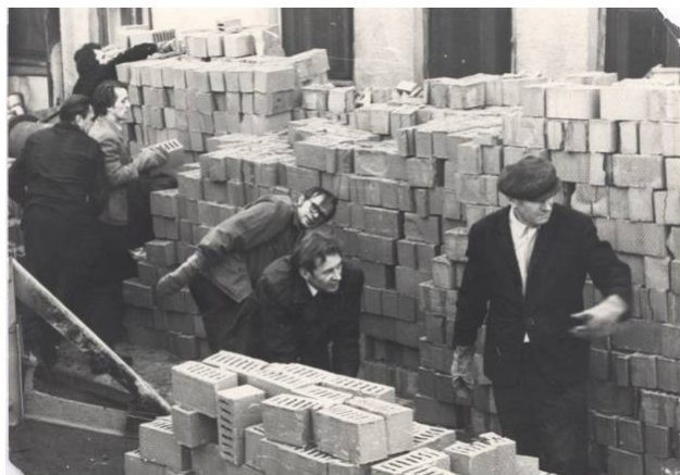
Рис. 2. Строительство нового здания ВГФ силами сотрудников
