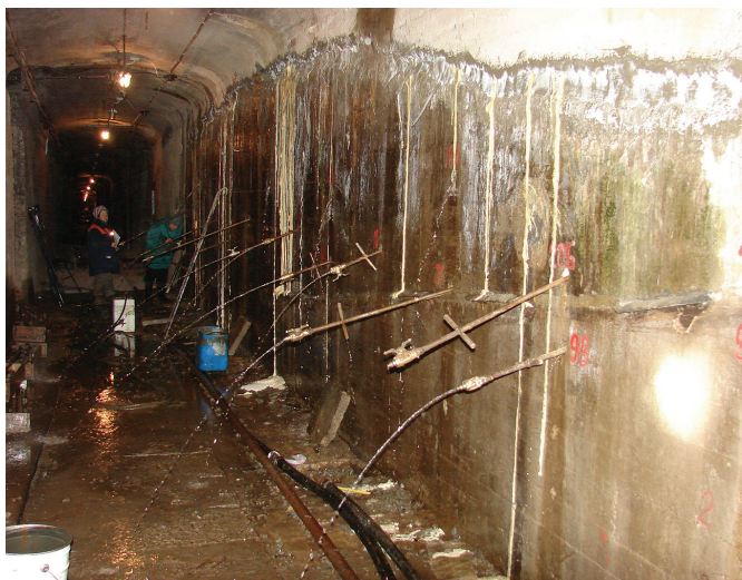
▲ Состояние горизонтальной трещины в процессе ремонта...
