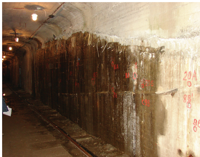
▲ и после выполнения ремонтных работ
