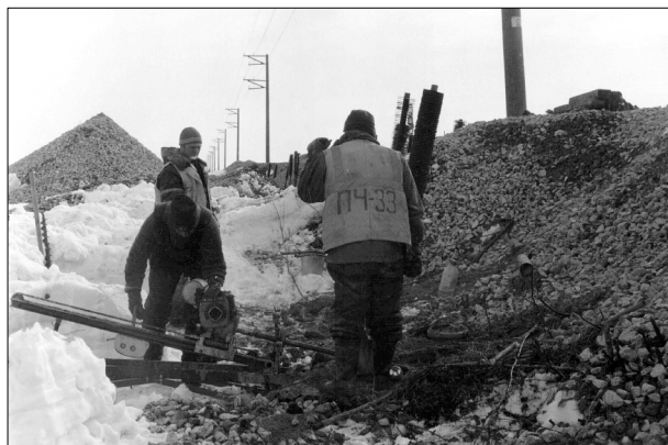
Рис. 17. Бурение наклонной скважины станком УКБ-12.5/25.
