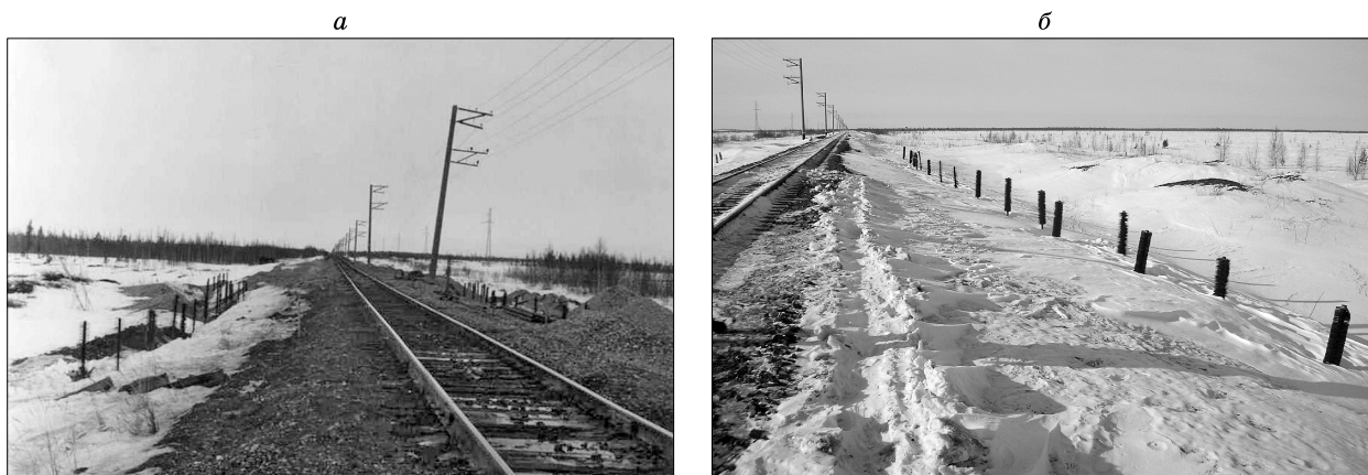
Рис. 18. Общий вид конструкции с длиномерными термосифонами после установки (а) и в зимний период (б).
