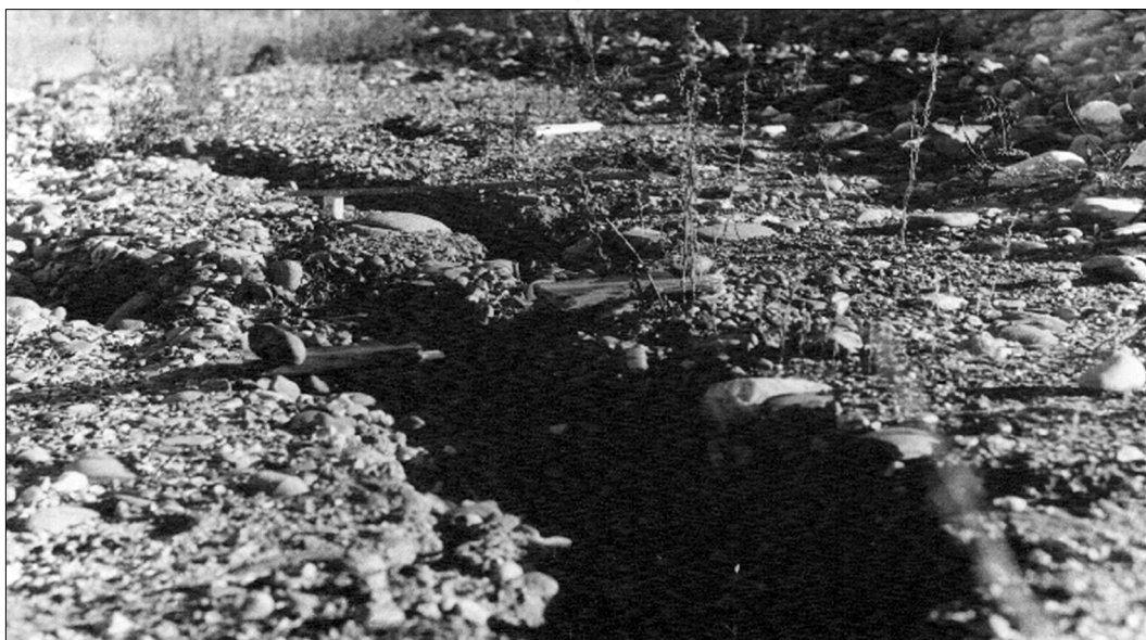
Рис. 4. Векторы перемещений поверхности различных частей насыпи в циклах осень–весна за три года (а) и трещины разрыва на обочине насыпи (б).
