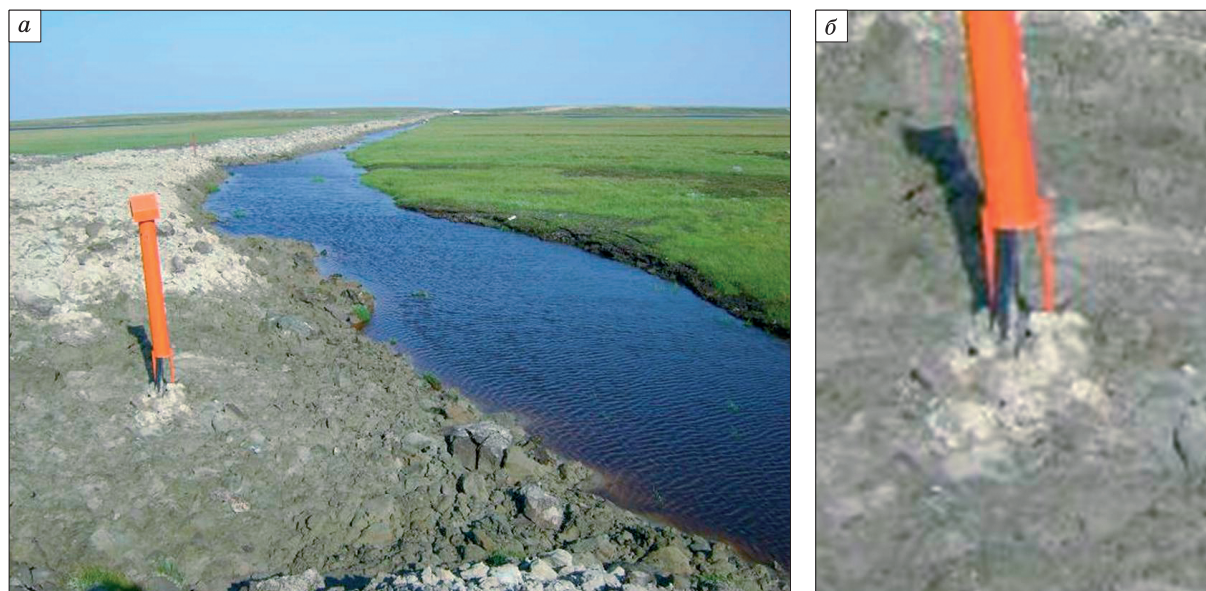
Рис. 2. Формирование протяженного техногенного термокарстового озера в результате подтопления территории обваловкой подземного трубопровода (а).
