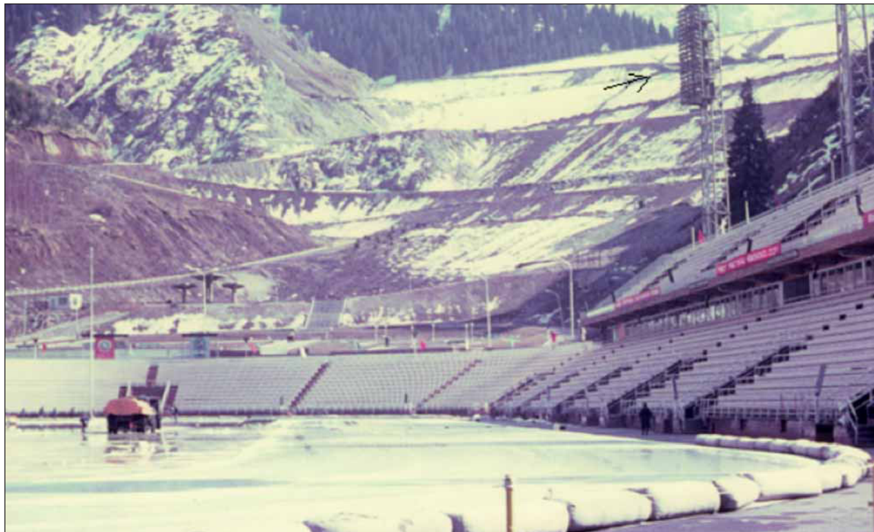
Рис. 1. Плотина Медео, остановившая катастрофический селя 1973 г. Снимок сделан с трибуны катка Медео в начале апреля 1977 г.: в горах еще лежит снег, низкая облачность. На плотине начаты работы по ее реконструкции — наращивание высоты и прокладка новой системы водосбросов. Стрелкой отмечено кафе «Ласточка», которое в 1973 г. находилось на верхнем уровне плотины. Слева от плотины видны оголенные склоны — следы направленного взрыва 1966 г. (фото В.С. Шibaковой)
