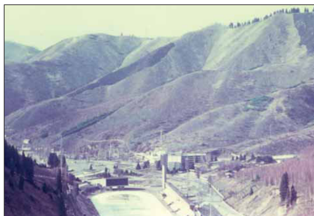
Рис. 2. Вид с гребня плотины Медео на север. На переднем плане в центре — каток Медео, слева — гора Мохнатка, справа на склонах видны результаты работ по рекультивации — посадки деревьев и кустарников (фото В.С. Шibaковой, апрель 1977 г.)
