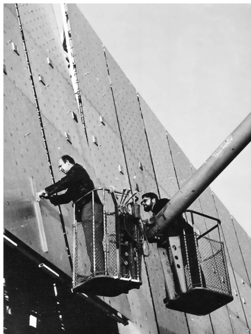
Закрепляют регулировочные винты для корректировки формы поверхности. Ю.Н. Парийский и ведущий конструктор А.И. Копылов. 1973 г.
