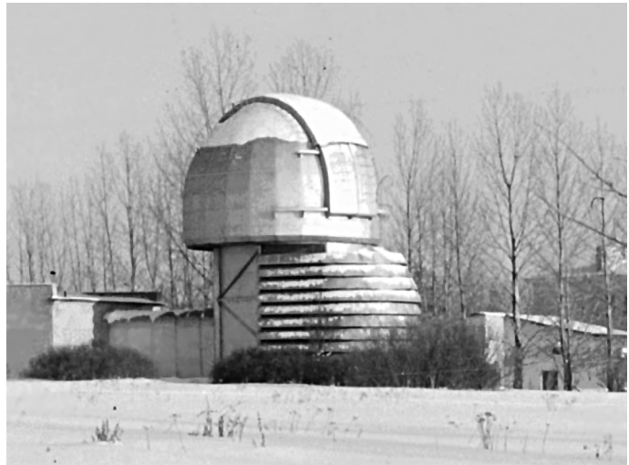
Металлическая (стальная) башня 600-мм рефлектора Пулковской обсерватории. Фото автора.
