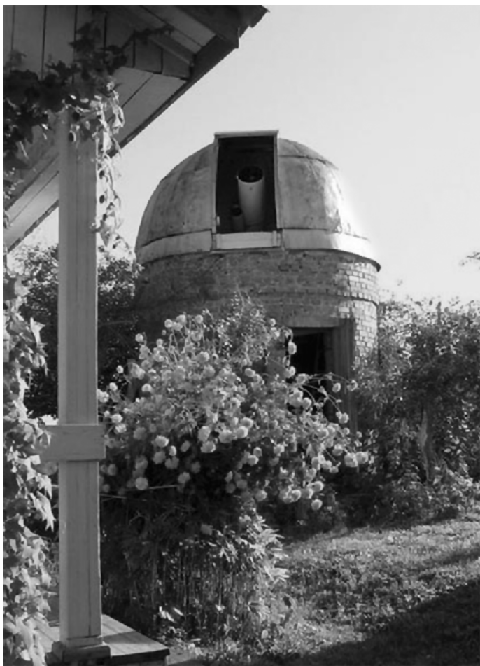
Башня обсерватории Л.Л. Сикорука. Фото автора.
