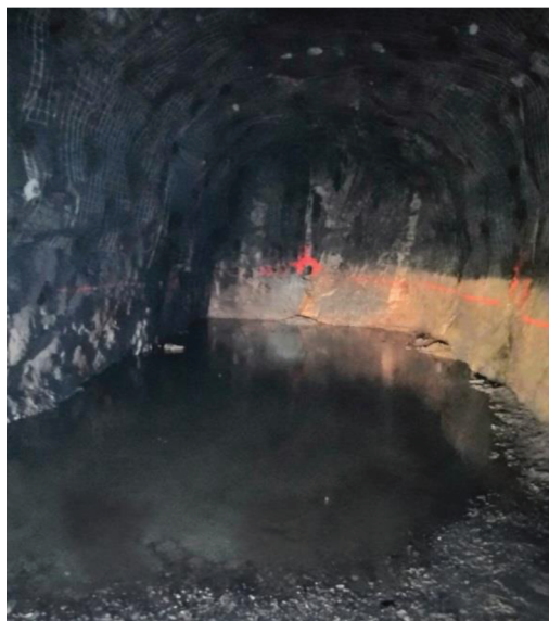
Рис. 6. Разгрузка подмерзлотных вод на горизонте +0 м (Северный участок месторождения “Купол”).
