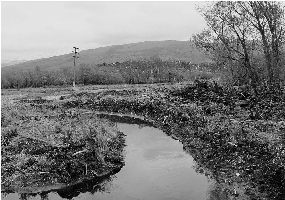
Рис. 3. Отводная канава, по которой талая вода с полигона-1 сливается в кювет автодороги, 28.05.2014 г.
