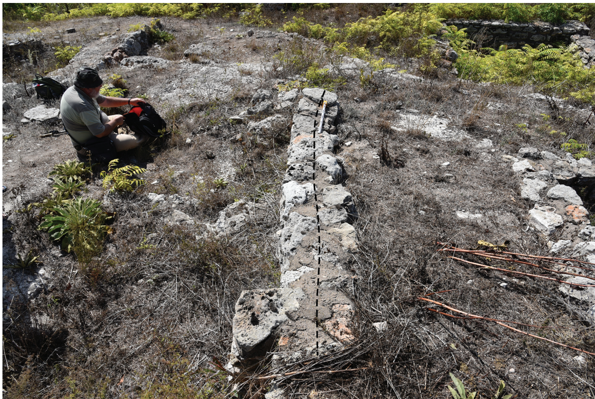
Рис. 13. Остатки стены построек со времени Первого Болгарского царства на Южном склоне острова. Они находятся к западу от святилища Великой богومатери Кибелы. Святилище находится в карстовой пещере на этом месте. Потолок в пещере провалился еще в древности. В середине фотографии к западу от стены видны природные скальные основы Острова, на которых виден сидящий человек. Видна сигмоидная деформация в плане стены субмеридионального простирания в южном квартале Дуранкулака (показана черной штриховой линией). Длина рулетки – 0.5 м. Вид на юг.
