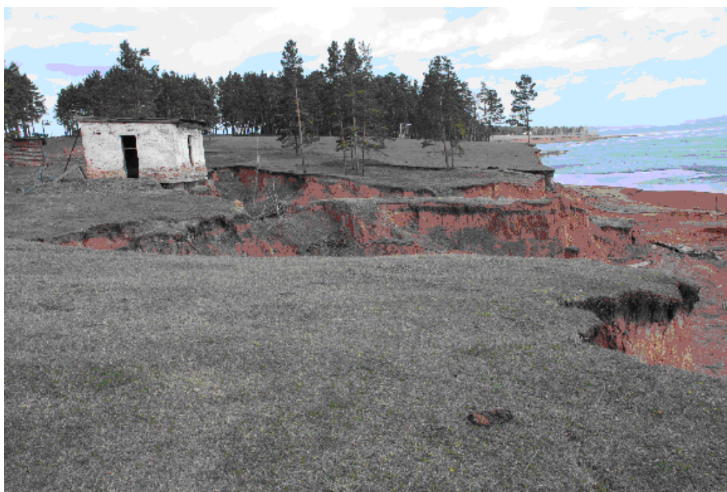
Рис. 4.10.20. Абразионно-эрозионный берег Братского водохранилища в районе н.п. Заславск 06.05.2009г. при уровне воды водохранилища 397,3 м БС
