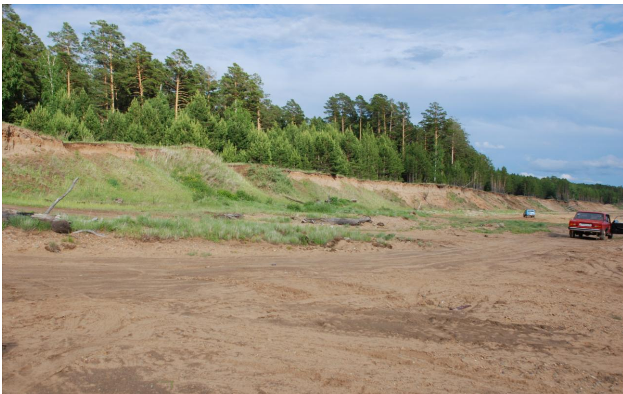
Рис. 4.10.23. Берегообрушение у н.п. Тангуй Братское водохранилище. 21.06.2009 г, уровень воды водохранилища 398,2 м. БС.
