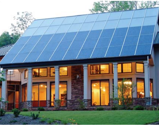
Солнечные батареи на крыше здания.
