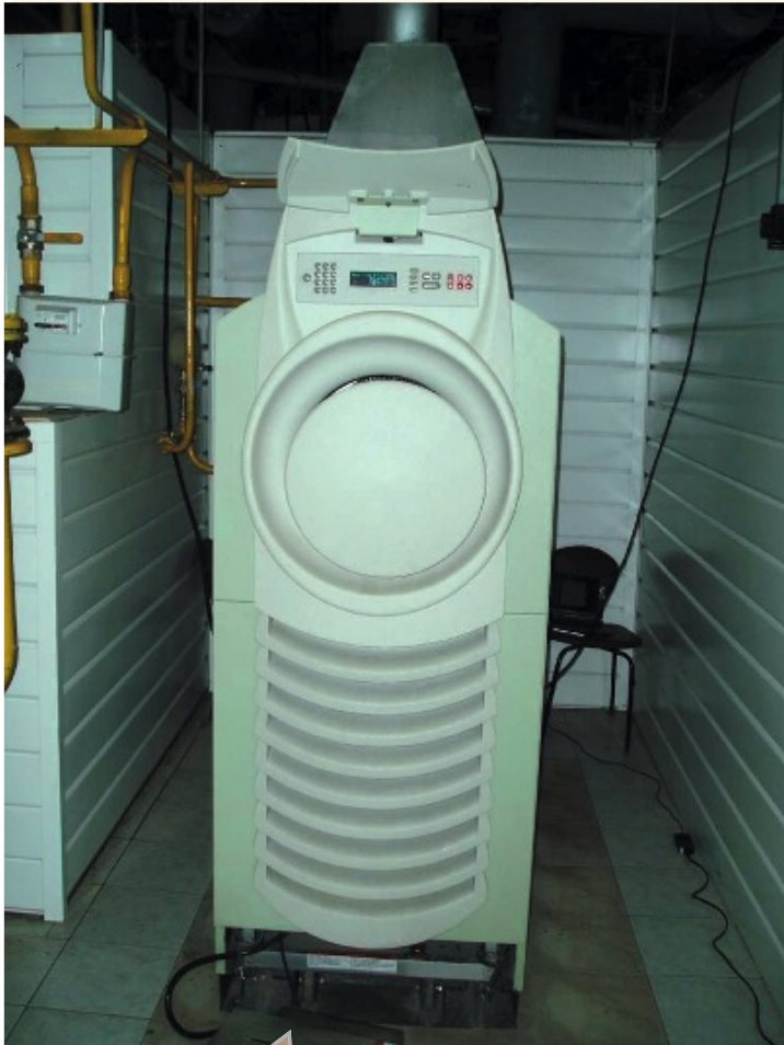
Газотурбинная установка мощностью 60 кВт американского производства.
