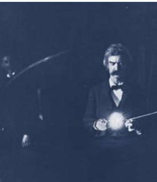
Марк Твен (Samuel Clemens) демонстрирует передачу энергии без проводов. Большая резонансная катушка (на снимке не видно) индуцирует ток высокого напряжения в проволочной петле, которую он держит в руках. Этот ток, проходя через тело Марка Твена без всякого вреда для него, заставляет светиться электрическую лампочку накаливания. Слева на заднем плане виден Тесла, управляющий аппаратурой.
