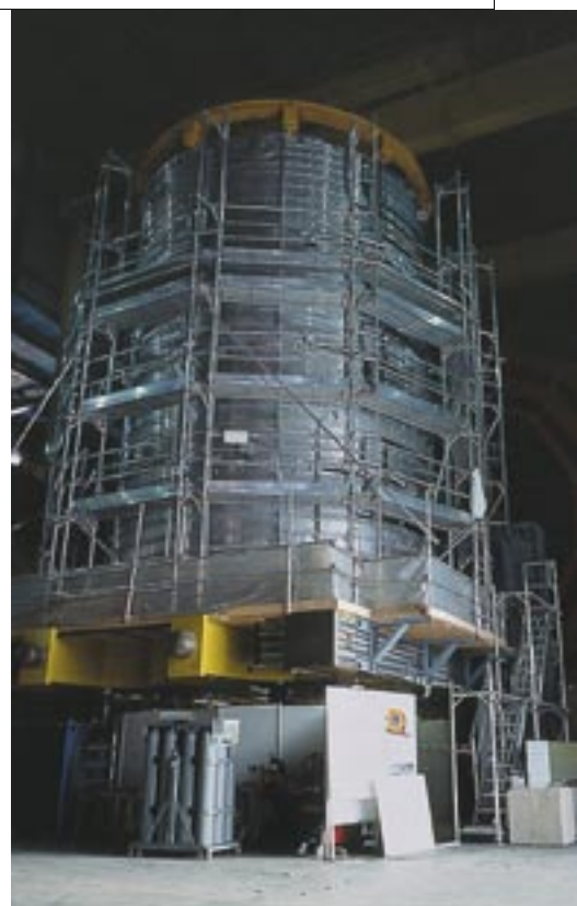
Монтаж сверхпроводящей обмотки соленоида.
