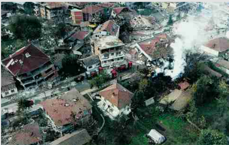
Обрушение зданий в Дюздже было вызвано сильным землетрясением в ноябре 1999 г. По мнению некоторых ученых, это бедствие было связано с произошедшим ранее толчком вблизи Измита.
