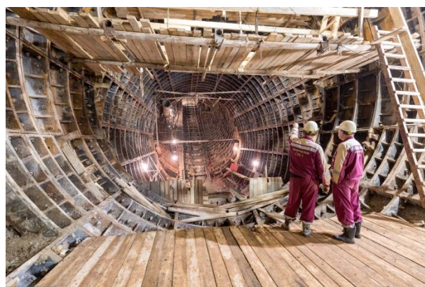
строительство станции метро «Верхние Лихоборы»
