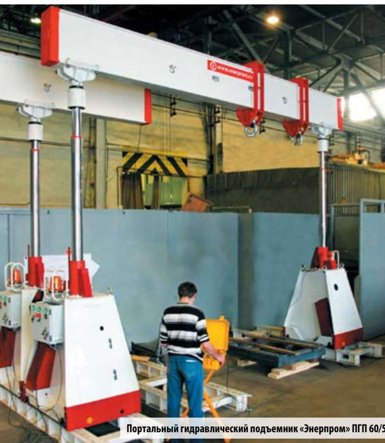
Производство монтажных работ с применением импортного порталного гидравлического подъемника
