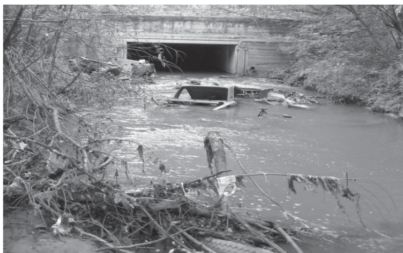
Рис. 4. Река Чертановка – у коллектора в районе Пролетарского проспекта (16.09.2008 г.).
