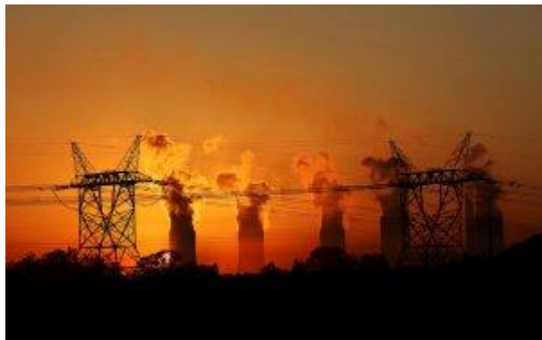
Тепловая электростанция Siphiwe Sibeko/Reuters
