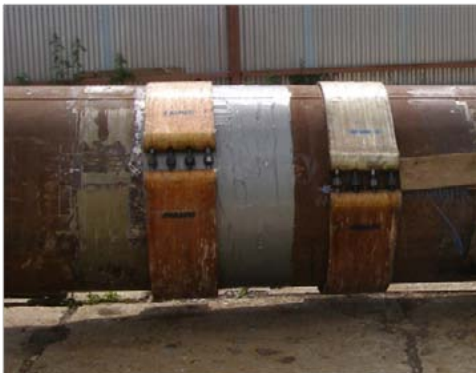
Рис. 1. Процесс монтажа муфты РСМ
