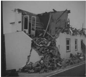
Fig. 19.11. Collapsed corner
