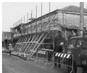
Fig. 16.18. Wooden propping (Etna 2002)
