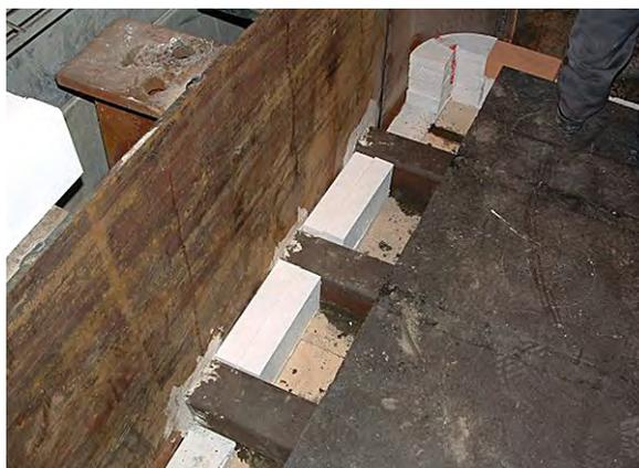
Рис. 6. Угловые и нестандартные детали изоляционных плит PROMASIL®
