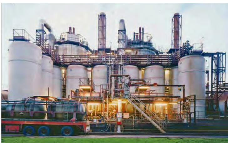
Рис. 18. Установка для переработки отработавшей кислоты и побочного оксида из травильного раствора [9]
