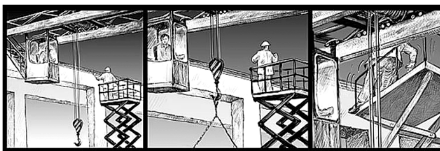
Рис. 7. Столкновение портального крана с мобильным подъемником в Льюсе в 2002 г. – Несчастный случай. Работа в зоне портальных подъемных кранов, чтобы предотвратить серьезные несчастные случаи, требует тщательного планирования, разъяснения и внимания
