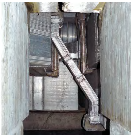
Рис. 1. Плавкая вставка S-образная
