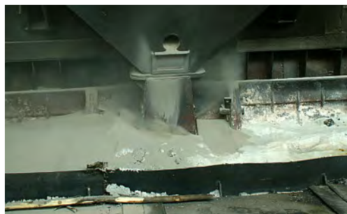
Рис. 5. Выбивание пыли из-под мундштука АПГ в момент загрузки в электролизер порции глинозема
