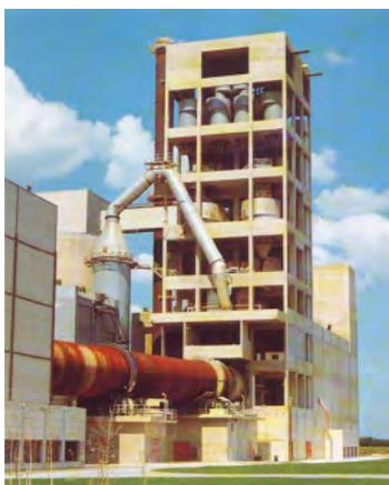
Рис. 1. Внешний вид установки сухого способа производства, печь  $\varnothing 4 \times 70$  м
