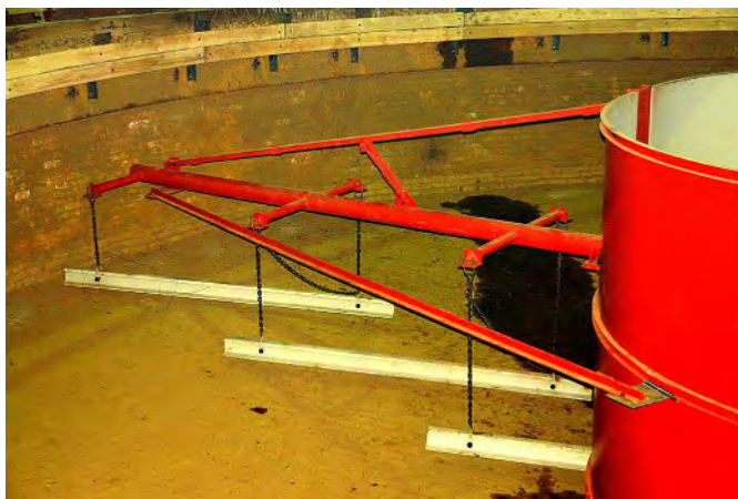
Рис. 1. Система шламоудаления волокушного типа
