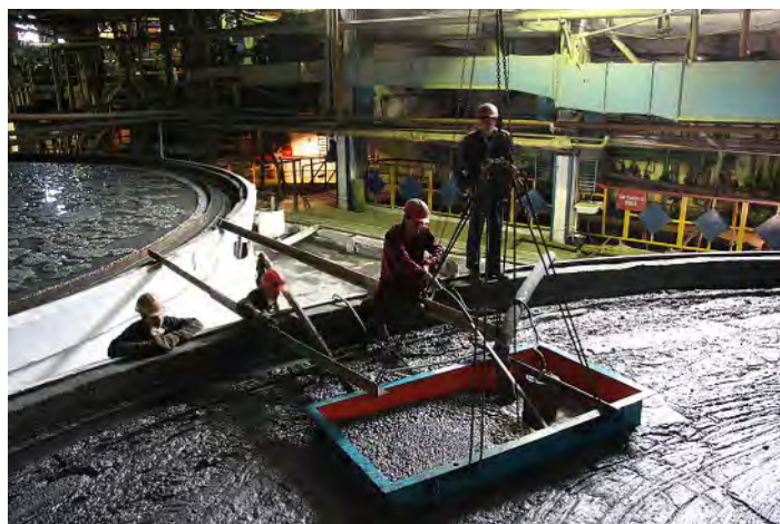
Рис. 4. Установка блока тонкослойного сгущения в радиальный сгуститель на фабрике РГОК АО «Казцинк»
