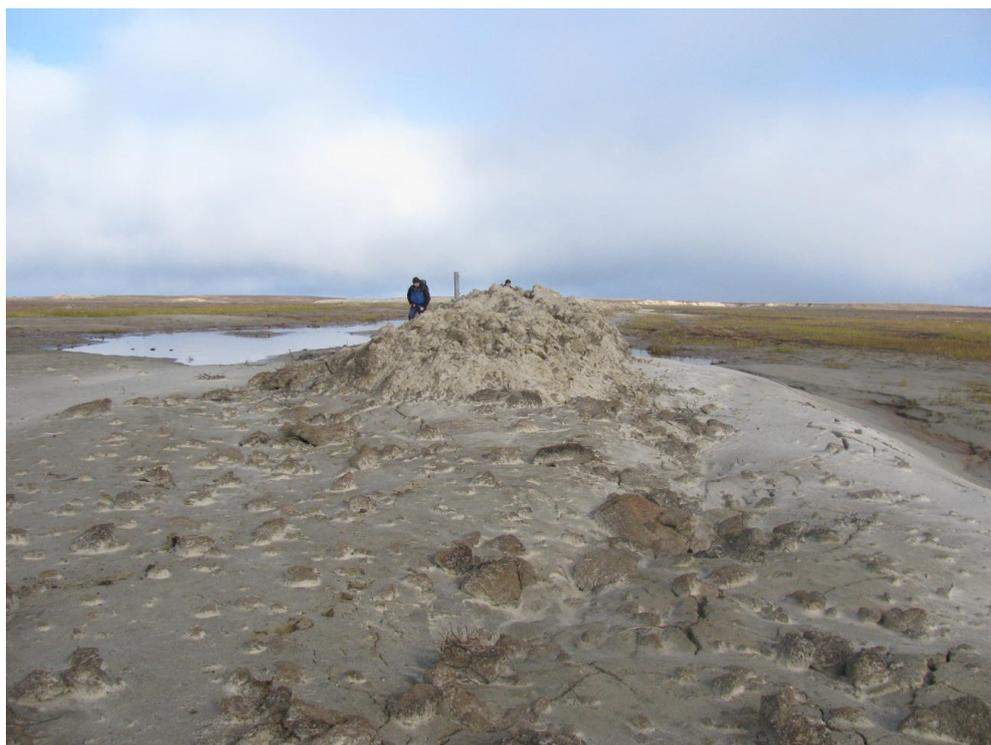
Рисунок 4 – Размыв насыпи при переходе хасырея
