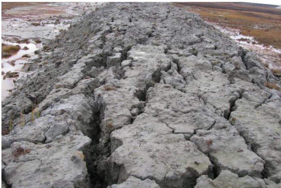
Рисунок 1 – Разрушение валика обратной засыпки
