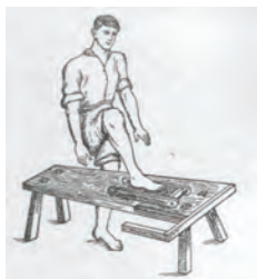
Рисунок 1. Формовка кирпича подпятным способом
