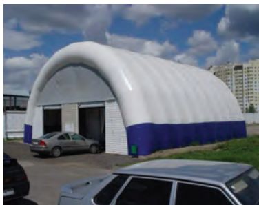
Рис. 2 Воздухонесомое сооружение мойки автомобилей Санкт – Петербург
