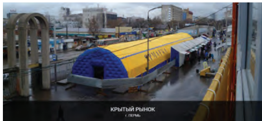
Рисунок 2 Пневматическое сооружение с воздуонесомыми арками
