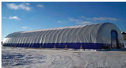
Рис 3. Комбинированное воздухоопорное сооружение, усиленное металлическими арками 2008 г. Ямал.
