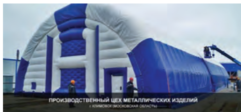
Рис.3 Мембранно - каркасное сооружение арочного типа г. Климовск
