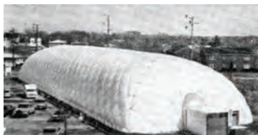
Рис. 1 Одно из первых пневматических сооружений спортивного назначения. 1980 г.
