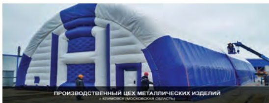
Рис.1 Воздухонесомое сооружение производственного назначения
