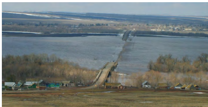
Рис. 2. Автомобильная дорога через р. Ток
