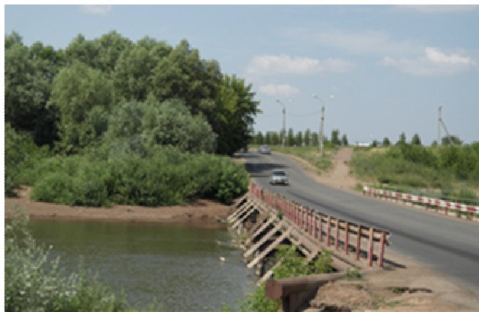
Рис. 1. Низководный мост через р. Самара в г. Бузулук
