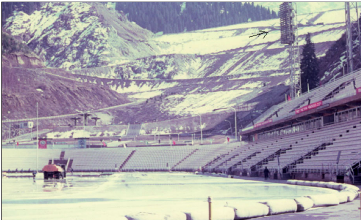
Рис. 1. Плотина Медео, остановившая катастрофический селя 1973 г. Снимок сделан с трибуны катка Медео в начале апреля 1977 г.: в горах еще лежит снег, низкая облачность. На плотине начаты работы по ее реконструкции — наращивание высоты и прокладка новой системы водосбросов. Стрелкой отмечено кафе «Ласточка», которое в 1973 г. находилось на верхнем уровне плотины. Слева от плотины видны оголенные склоны — следы направленного взрыва 1966 г. (фото В.С. Шибаковой)
