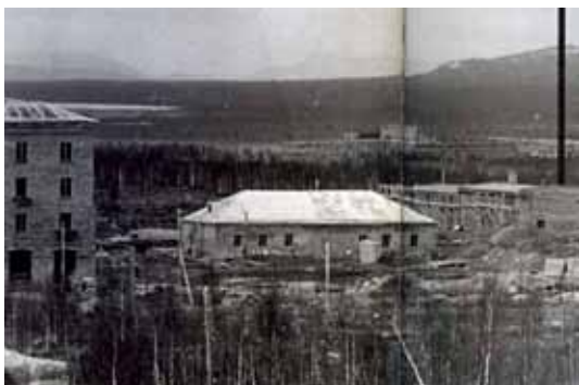
Так начинались Апатиты. Строящееся здание сейсмостанции.
