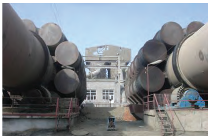
Рис. 1. Печи с рекуператорами
